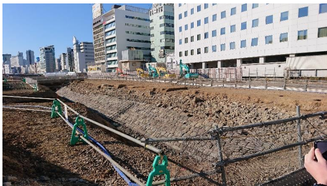
○これは海側の築堤です。波の浸食をおさえるためになだらかな角度が付いています。
