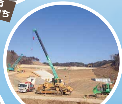
岩手県宮古市 造成中の様子
